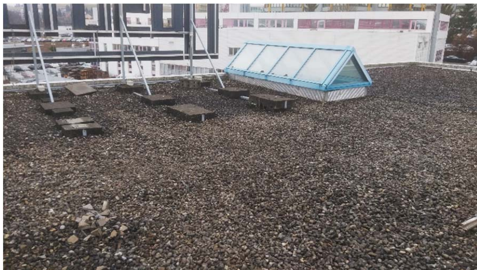
Abbildung 3: Situation nach der Demontage der Messvorrichtung
