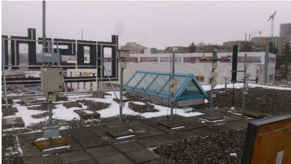
Abbildung 2: Dach mit Testmesseinrichtung zur Erfassung von Klimadaten
